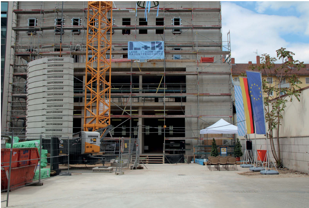
Der Bauteil F am Tag des Richtfests: In Kürze werden hier Mitarbeiterinnen und Mitarbeiter des Landesamts ihre Arbeit aufnehmen.
